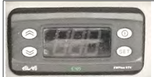
Fig. 1: quadro con unità condensante
