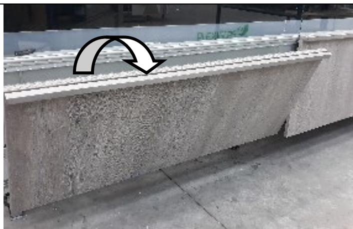
Fig./pic. 4: rimozione pannello frontale
