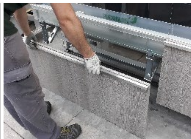
Fig./pic. 6: rimozione pannello frontale
