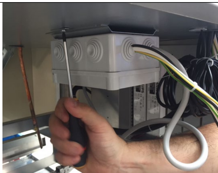
Fig. A: allentare leggermente le viti di bloccaggio.
